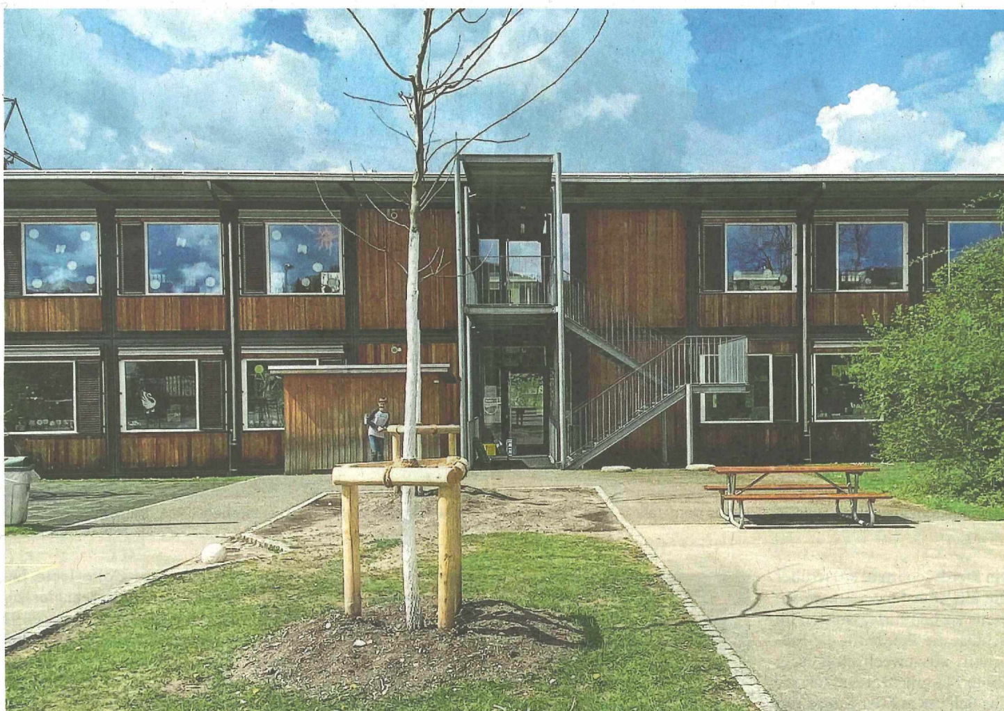
Im Holzpavillon ist ein Teil der Tagesbetreuung untergebracht. Mit dem Neubau würde er abgerissen.
